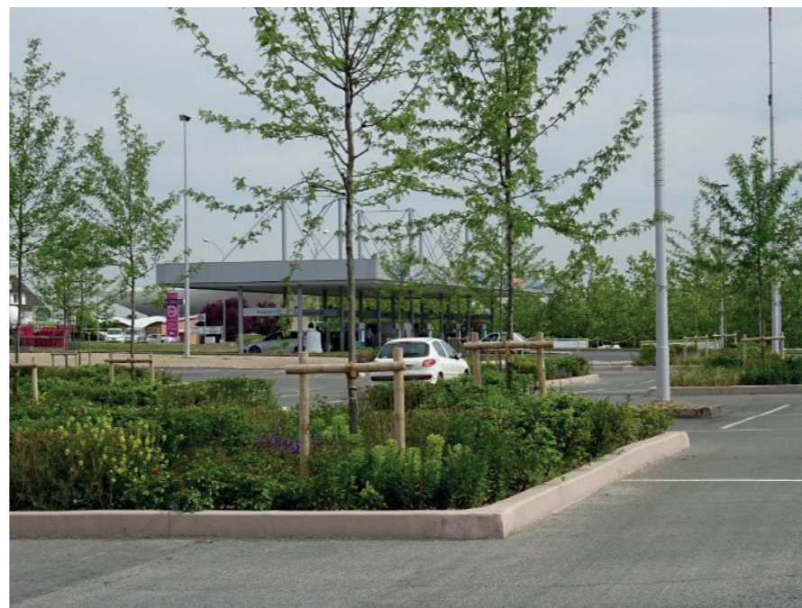
Figure 41 : Traitement de la bande séparative par haie vive, vivaces et plantation d'arbres
