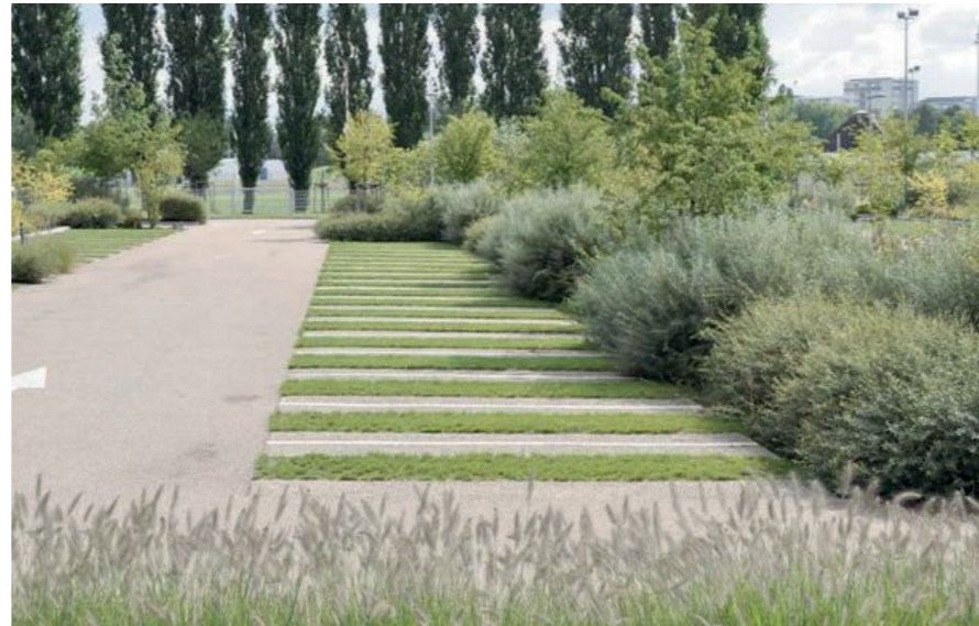
Figure 40 : Exemple d'aménagement perméable avec bande de roulement
