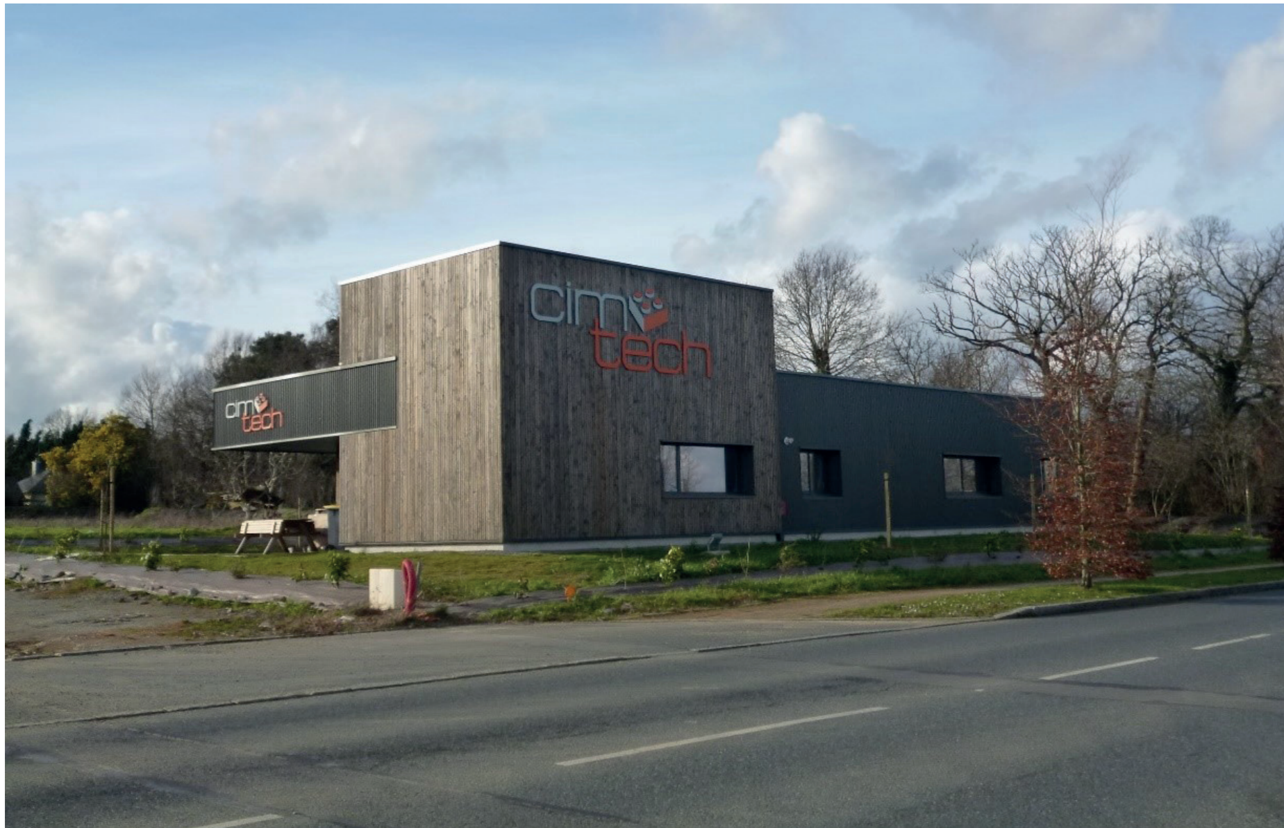
Figure 25 : Aménagement d'un préau dans la continuité du bâtiment
