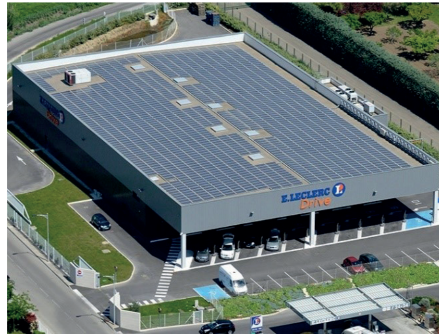
Figure 30 : Exemple de toiture
