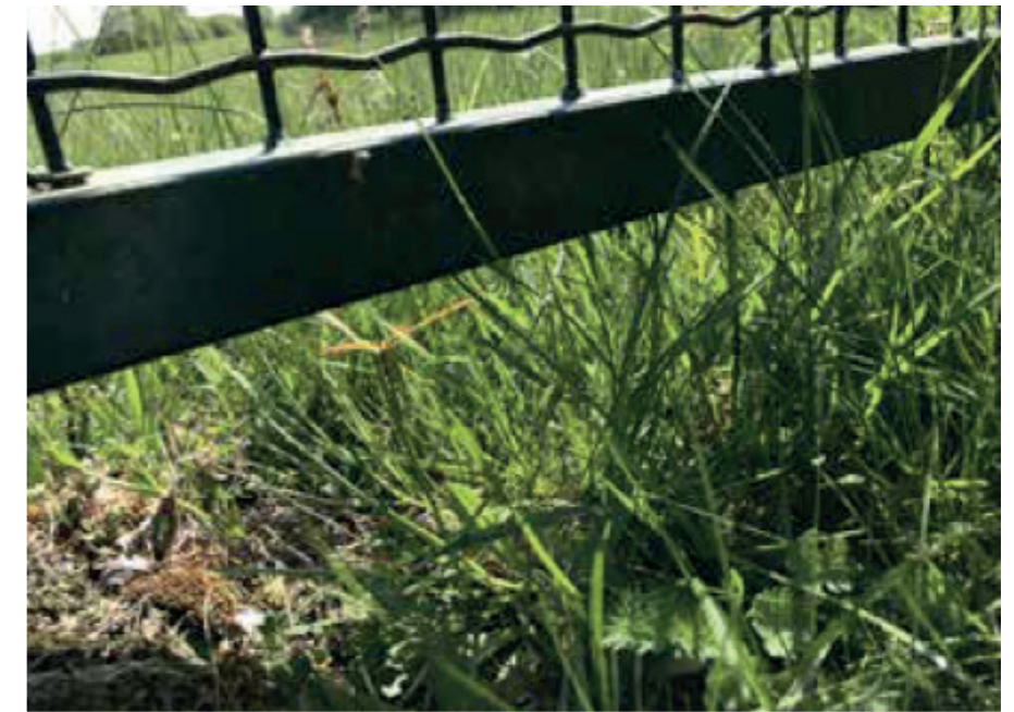
Figure 32 : Clôture laissant passer la petite faune
