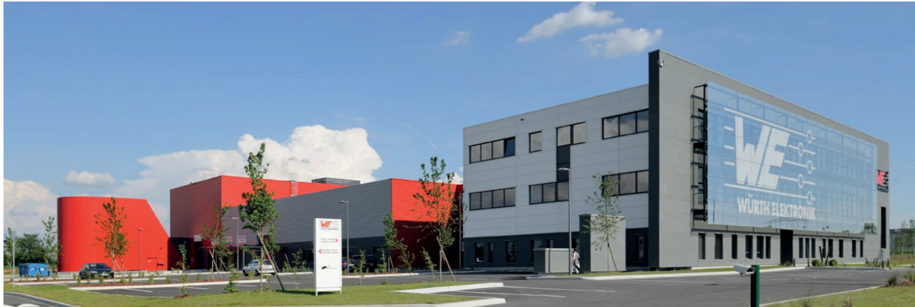
Figure 24 : Prolongement de la façade « vitrine »
